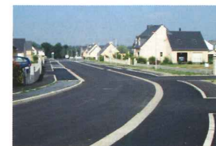
Lotissement du Lattay
